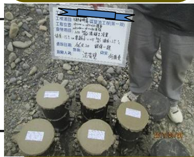
混凝土試體取樣
