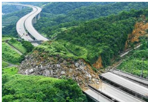
國道三號崩塌
