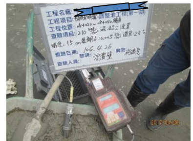
混凝土氯離子試驗
