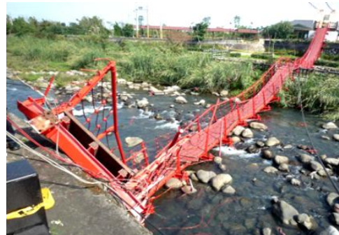
三芝吊橋斷裂
