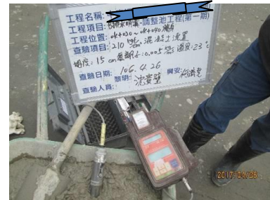
混凝土氯離子試驗
