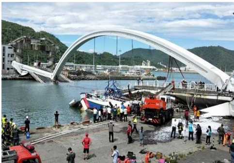
南方澳大橋斷裂
