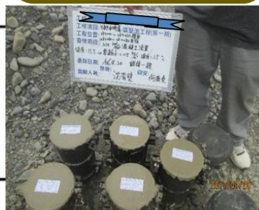
混凝土試體取樣
