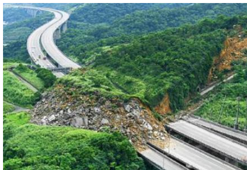
國道三號崩塌
