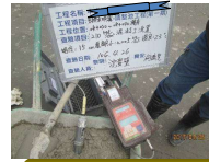
混凝土氯離子試驗
