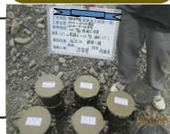
混凝土試體取樣
