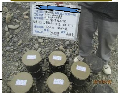
混凝土試體取樣
