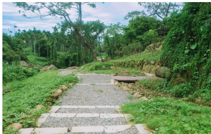
古坑鄉華南生態公園綠廊道建置工程 (112年第23屆公共工程金質獎)
