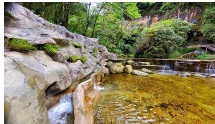
110年度阿里山事業區第107林班保育治理工程-仿岩工法融入自然 (111年第22屆公共工程金質獎)
