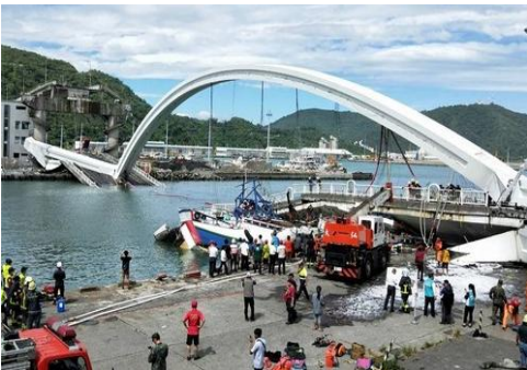
南方澳大橋斷裂
