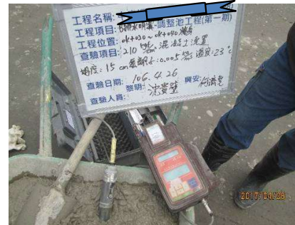
混凝土氯離子試驗
