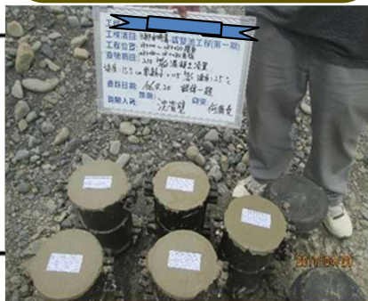
混凝土試體取樣
