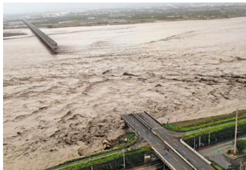
雙園大橋斷裂
