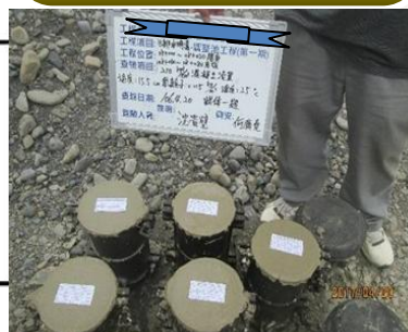
混凝土試體取樣
