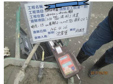
混凝土氯離子試驗
