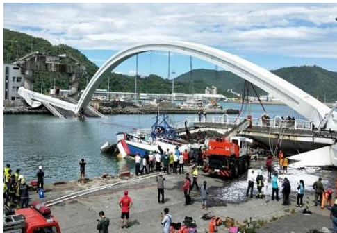
南方澳大橋斷裂
