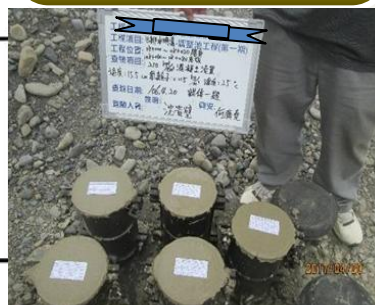
混凝土試體取樣
