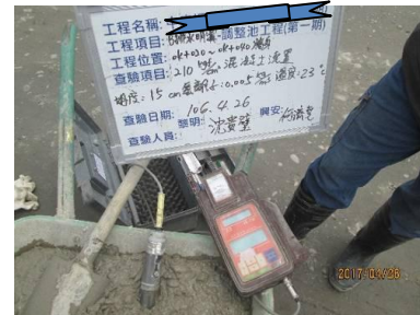
混凝土氯離子試驗
