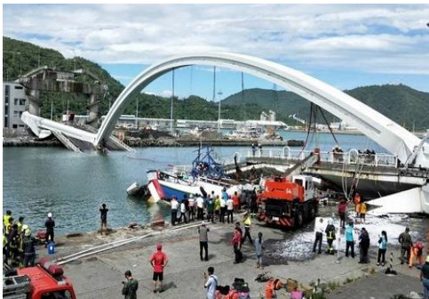
南方澳大橋斷裂
