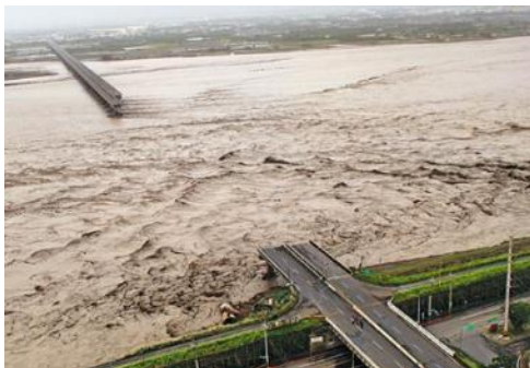
雙園大橋斷裂
